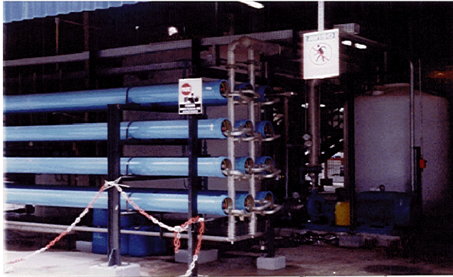
Sistema de Reciclagem de Água Processo com O 3 +Flotação+Filtro Areia+Nanofiltração
